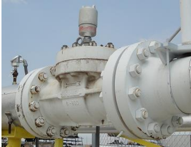
Fig 25. CEESI 8" Turbine Meter.
